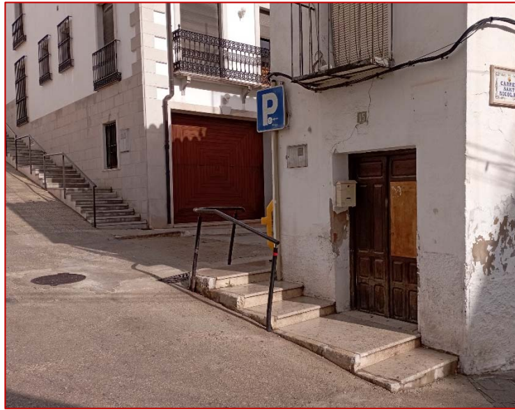
Ilustración 3. Modelo de barandilla existente en c/Cantó del Batle que sustituirá a la existente.
