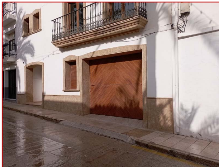
Ilustración 4. Vado existente en la calle San José.
