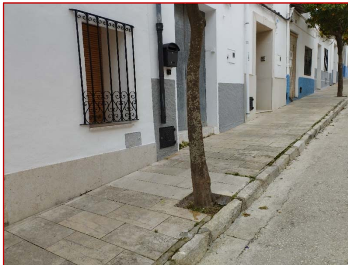
Figura 10. Alcorques en la calle Padre Zacarías
