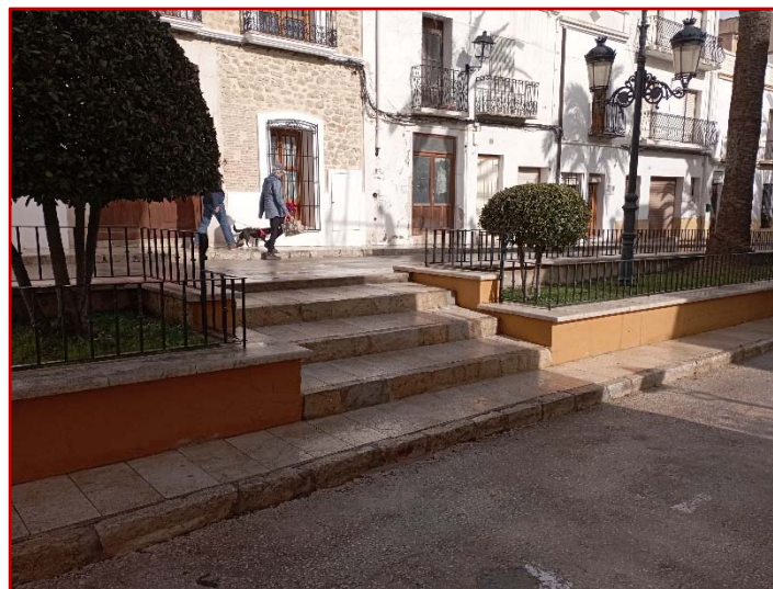
Ilustración 6. Vista de las escaleras de la calle San José.
