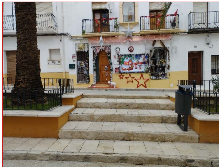
Figura 8. Vista de las escaleras de la calle San José
