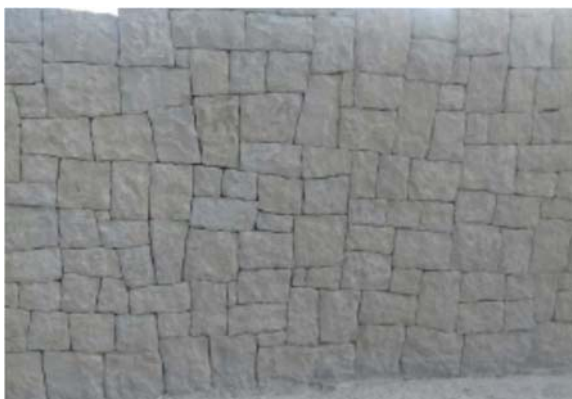
Figura nº1: Imagen de muro revestido con mampostería tipo “marge”
